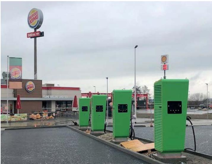
DC-Schnellladestationen mit einer Leistung von bis zu 300 kW –
