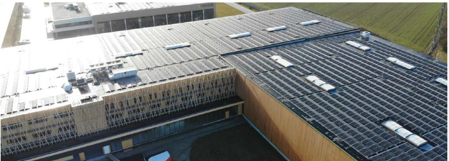
Sonnenkraftwerk auf dem Dach der Produktionshalle mit einer Leistung von 1,5 Megawatt (entspricht dem Jahresstrombedarf von ca. 600 Haushalten)
